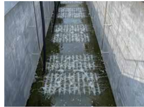
连云港某污水处理项目
