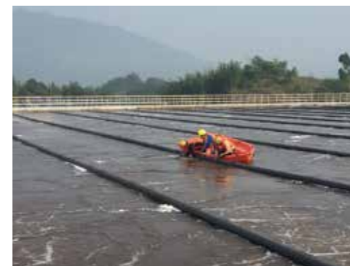
四川某造纸废水悬挂链项目
