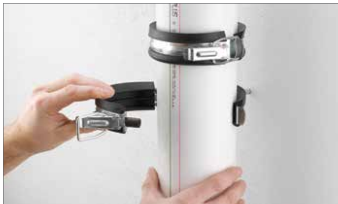
Fig. 8-2 Sluiten van de doorvoerbeugel
