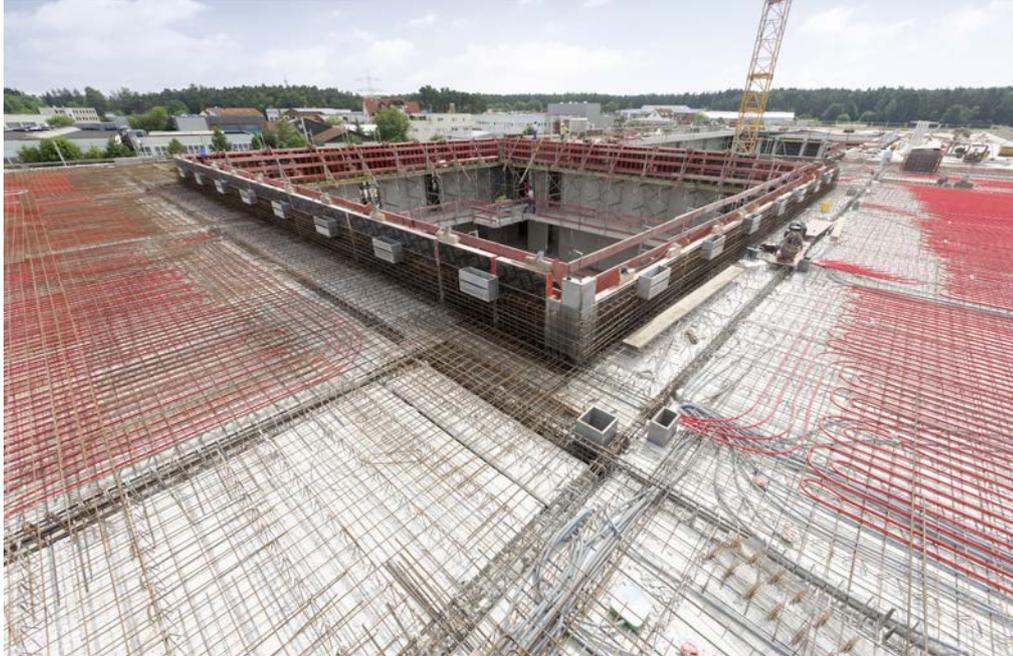
Geringe Investitions- und Betriebskosten, hohe Behaglichkeit, baustellentaugliches PE-Xa-Rohr mit hohen Sicherheitsreserven sowie schnelle und einfache Verlegung zeichnen die REHAU Betonkern-temperierung aus. **3.800 m<sup>2</sup> BKT-Module** wurden verlegt.
