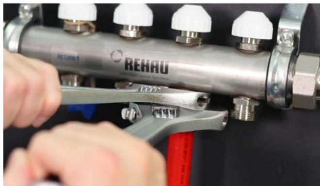
7. Poussez la bague fendue vers le haut du tuyau jusqu'à ce qu'elle soit au niveau de la surface angulaire de la douille.
