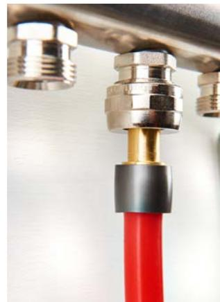
8. Répétez les étapes 1 à 7 pour tous les raccords de sortie. Si certaines sorties de circuit ne sont pas utilisées sur le collecteur, utilisez le bouchon de sortie de circuit R-20 (art. n° 250209-C).
