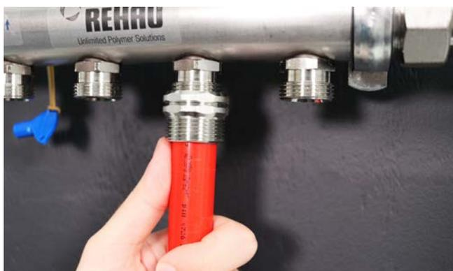
6. Utilisez deux clés pour serrer la douille sur la sortie du collecteur. L'une permet de serrer la douille et l'autre pour maintenir la sortie du collecteur et éviter ainsi d'endommager le tuyau de sortie.
