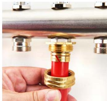
8. Utilisez deux clés pour serrer. L'une permet de maintenir la douille et l'autre de serrer l'écrou de compression à 12 Nm ou 9 pi-lb. Cela correspond à environ 1/2 tour lors du serrage à la main.
