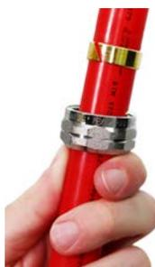
3. Placez la douille sur l'extrémité du tuyau en plaçant les filetages mâles orientés vers l'écrou de compression.
