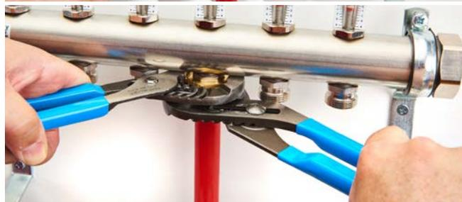
**AVIS :** Ne serrez pas trop. Un serrage excessif peut déformer la bague fendue ou fissurer la sortie du collecteur, ce qui entraînerait une fuite.
