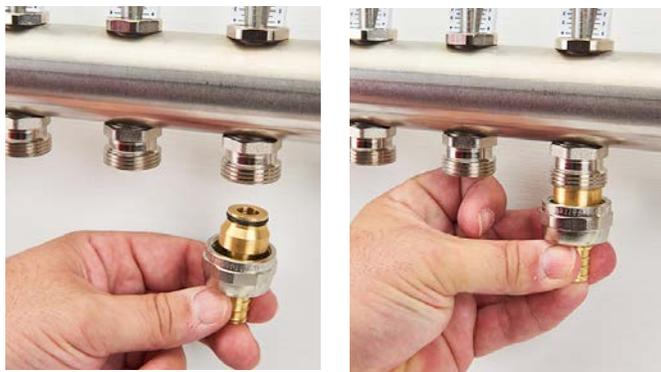
2. Serrez à la main l'écrou tournant, en veillant à ce que le raccord soit complètement enfoncé dans la sortie.
