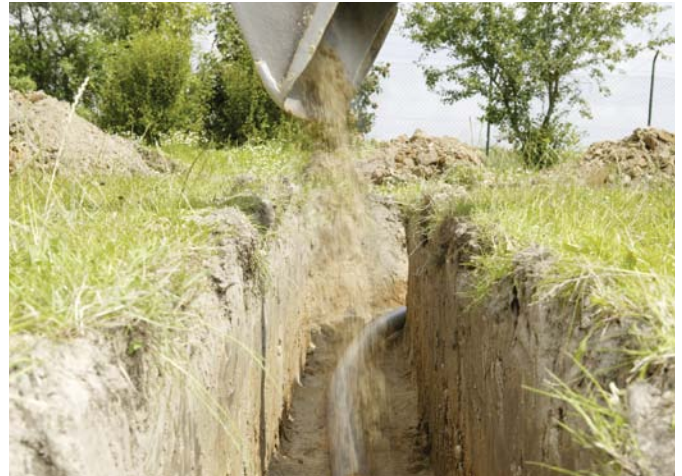
Abb. 56 Rohrgraben mit Sand füllen
