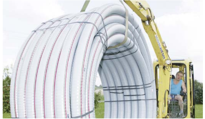
Abb. 47 Aufnehmen mit dem Bagger
