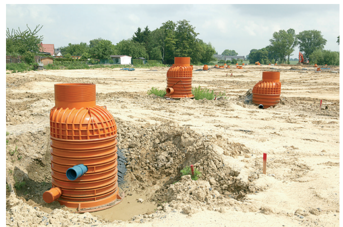
Ontwikkeling nieuwbouw 80 x TWINSCHACHT PP DN 1000
