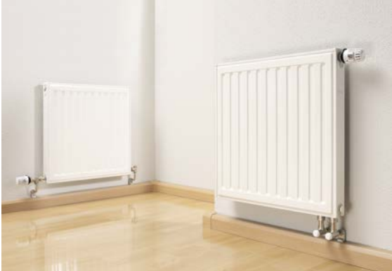
Abb. 18-1 Heizkörper-Anschluss aus der Sockelleiste
