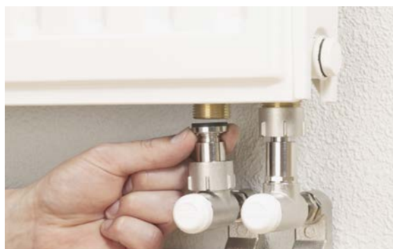
Abb. 18-8 Anschluss Teleskop-Eckverschraubungs-Set
