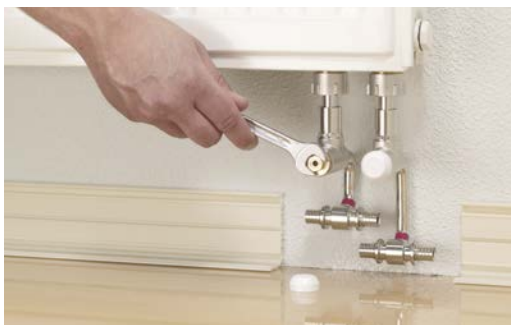
Abb. 18-12 Klemmringverschraubung fest anziehen
