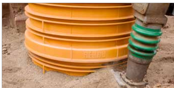
Afb. 5-31 Vullen en verdichten van de schachtomgeving
