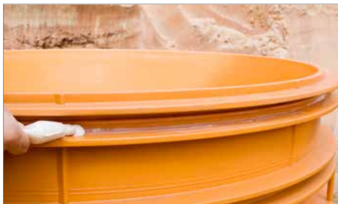
Afb. 5-26 Bovenste afdichtkamer met glijmiddel insmeren
