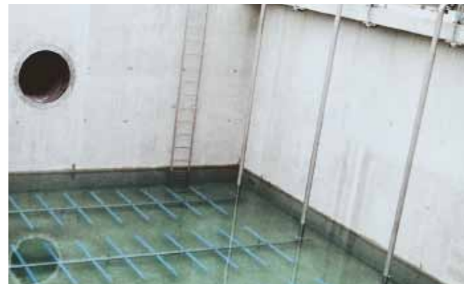
Extra drukverlies door beluchter met terugslagklep
