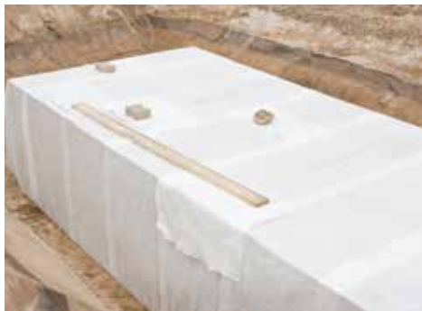
RAUSIKKO Box omhuld met een geotextiel
