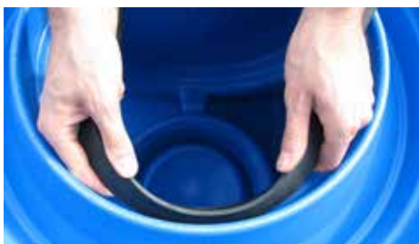
Plaatsing van de afdichtingsring in de buisaansluiting
