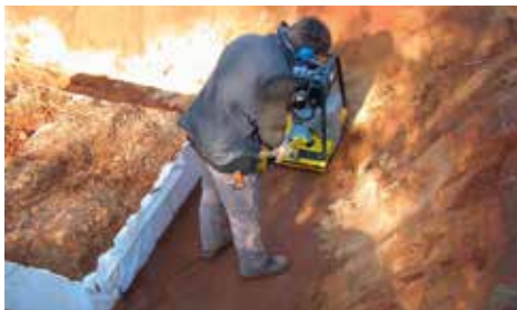
Verdichting van de werkzone naast het bekken
