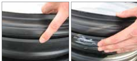
Plaatsen van de afdichtingsring tussen de eerste en tweede golving en insmeren met smeermiddel
