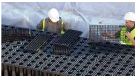
Plaatsing van de modules
