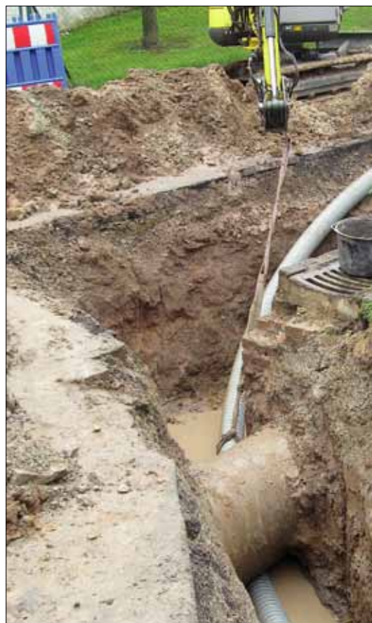
Bild 1. Um Ecken und Kanten: Aufgrund der Flexibilität der Kunststoffrohrleitungen können Hindernisse umgangen und Richtungsänderungen mit wenig Aufwand realisiert werden
