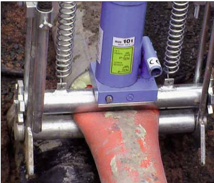
Bild 3. Mit einer speziellen Vorrichtung lässt sich der Fluss durch das Mediumrohr aus Kunststoff z. B. im Rahmen nachträglicher Anschlussarbeiten problemlos unterbrechen; anschließend nimmt die Leitung aufgrund des Memory-Effekts wieder ihre ursprüngliche Form an – dies liegt am in der Produktion des Kunststoffrohrs hergestellten stabilen dreidimensionalen Netzwerk aus Makromolekülen
