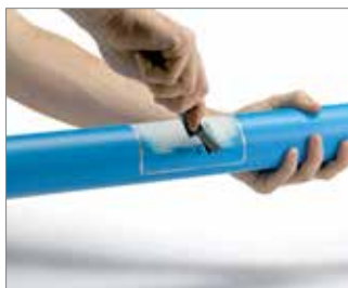
Rys. 55 2. Usunąć warstwę wierzchnią (o grubości ok. 0,2 mm) z zaznaczonej powierzchni rury.
