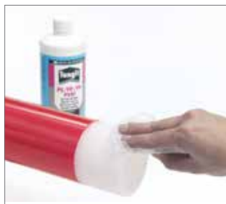
Rys. 95 Obszar po zeszkrobaniu warstwy zewnętrznej trzeba oczyścić z kurzu i tłuszczu. W razie potrzeby użyć środka czyszczącego Tangit, odczekać do całkowitego odparowania.
