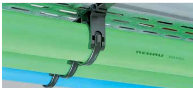
Rys. 129: Rury RAUPEX ułożone pod lub obok systemu koryt kablowych
