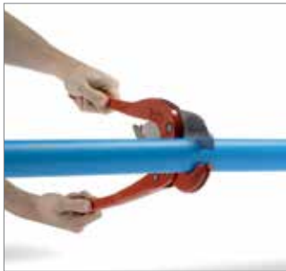
Rys. 40 1. Przyciąć rurę na żądaną długość pod kątem prostym i z zachowaniem gładkich krawędzi.
