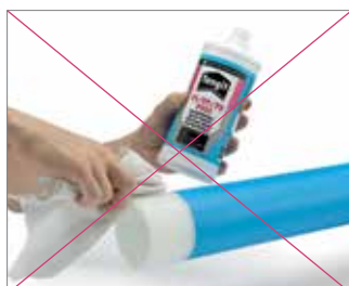
Rys. 75 Do czyszczenia nie używać zabrudzonych ściereczek. Stosować wyłącznie nowe, niefarbowane, niewłókniste, chłonne ręczniki celulozowe.
