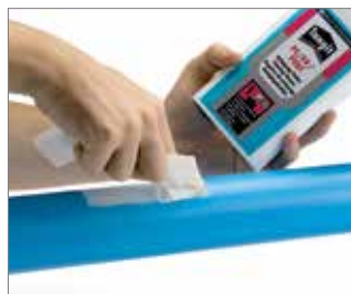
Rys. 56 3. Obszar zgrzewania musi być czysty. W razie potrzeby oczyścić go z kurzu i tłuszczu przy pomocy środka Tangit.
