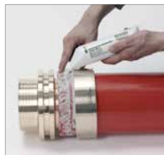
Rys. 32 7. W miejscu połączenia należy na całym obwodzie rury równomiernie rozprowadzić środek ślizgowy.
