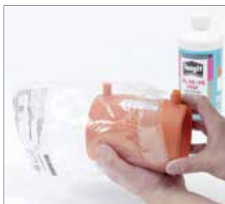
Rys. 96 Wyjąć mufę elektrooporową z woreczka. Jeśli jest to niezbędne, oczyścić przy pomocy środka Tangit.
