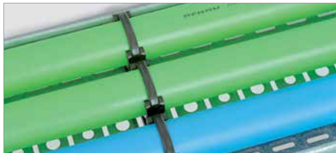
Rys. 128: Rury RAUPEX ułożone w systemie koryt kablowych
