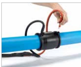
Rys. 52 13. Po zakończeniu zgrzewania włączy się sygnał dźwiękowy. Na wyświetlaczu pojawi się napis „OK”. Wyjąć przewody z gniazd.
