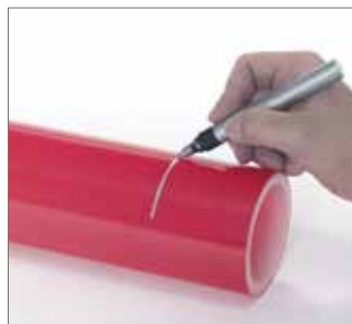
Rys. 111 Do naniesienia oznaczeń należy użyć pisaka w kolorze kontrastującym z rurą.
