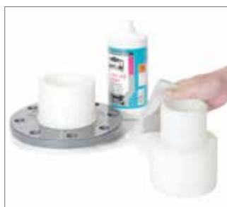
Rys. 117 Kształtek kołnierzowych i redukcji nie skrobie się, lecz jedynie czyści przed zgrzewaniem.
