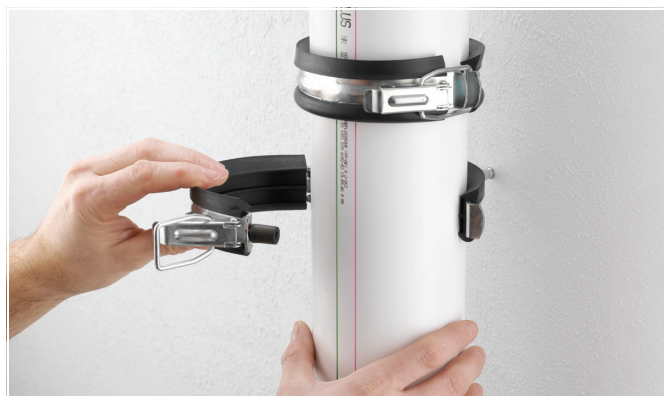
Rys. 6-2 Zamknięcie obejmy podtrzymującej
