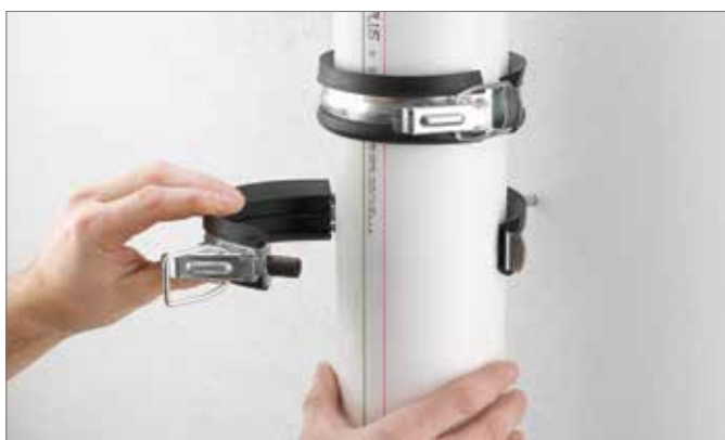
Rys. 6-2 Zamknięcie obejmy podtrzymującej
