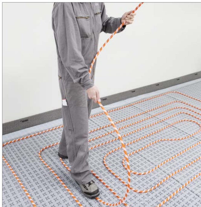
Rys. 3-6 RAUTHERM SPEED – montaż rur
