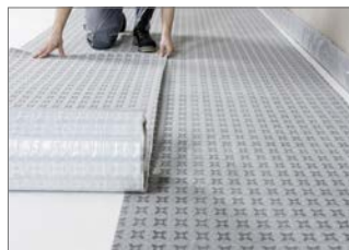
Rolka z zakładką o szerokości min. 5 cm wzdłuż krawędzi podłużnej
