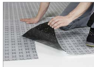
Rolka z zakładką o szerokości min. 10 cm wzdłuż krawędzi poprzecznej
