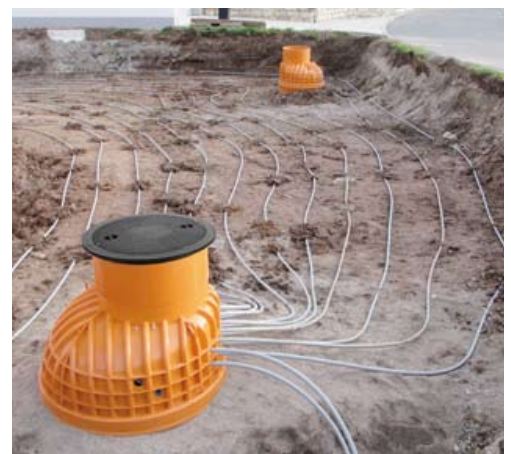
Układanie kolektorów geotermalnych RAUGEO
