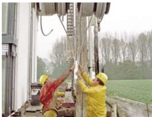
Montaż sondy geotermalnej RAUGEO
