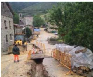
En Okina se suministra calefacción a distancia a todos los habitantes de forma respetuosa con el medio ambiente por medio de una red de tuberías de 500 m.
