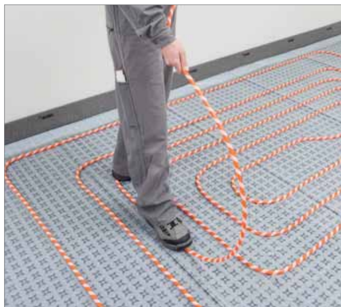
Fig. 6-43 Instalación del tubo
