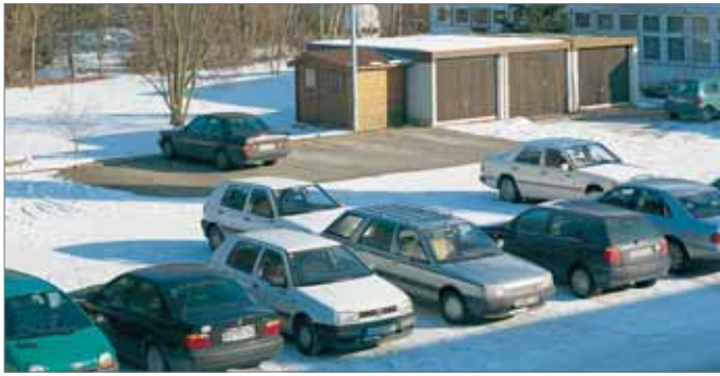
Fig. 16-41 Calefaccionado de un aparcamiento
