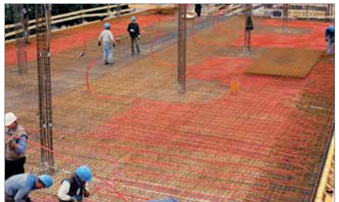
Fig. 15-5 Puesta en obra de REHAU BKT
