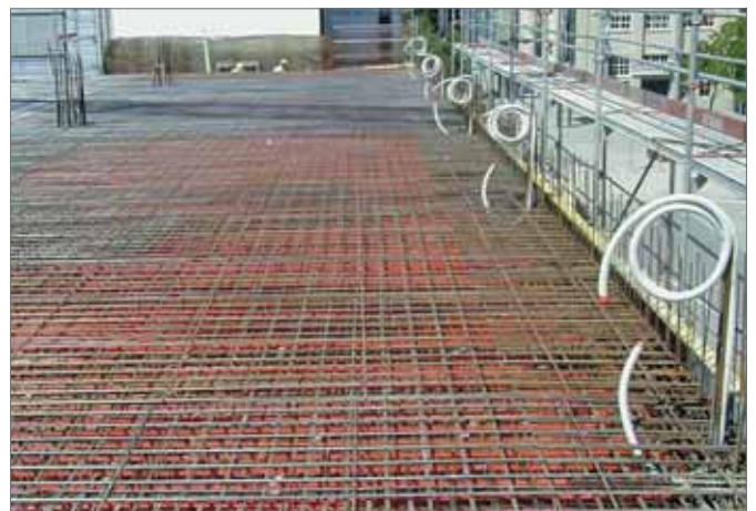
Fig. 15-2 Instalación de forjado radiante
