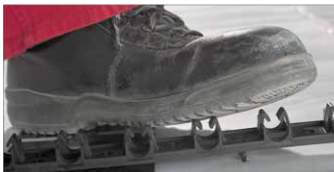
Fig. 6-78 Presionar la guía RAUFIX en el panel aislante
