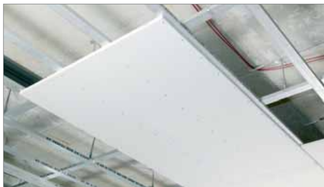
Fig. 7-8 Fijación de los elementos de techo
