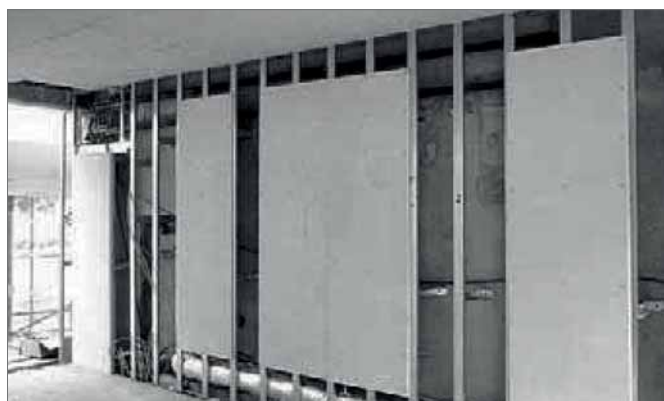
Fig. 7-38 Panel radiante para pared una vez instalado en pared
