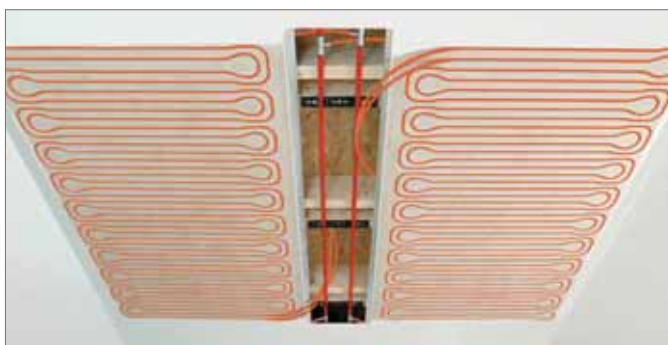
Fig. 7-1 Sistema techo radiante
