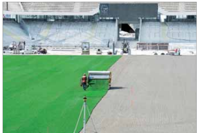
Fig. 16-46 Colocación del césped en rollo
