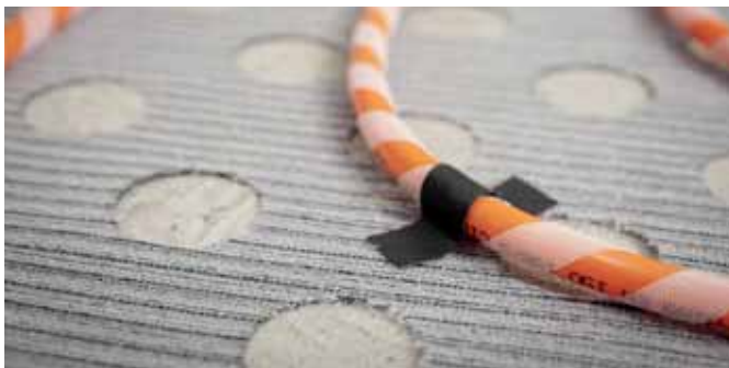
Fig. 6-70 Ejemplo de aplicación de la cinta de autofijación RAUTHERM SPEED
