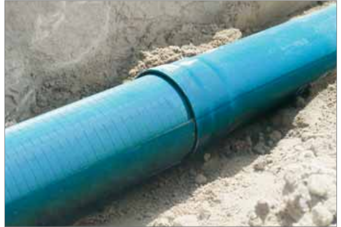
Fig. 16-44 Instalación del drenaje en el campo de juego
