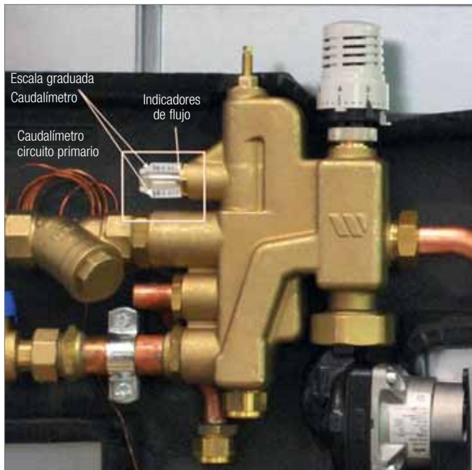
Fig. 9-46 Regulación del circuito primario
