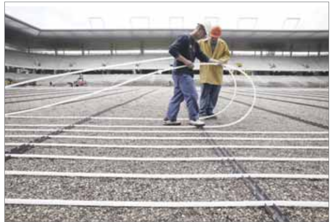
Fig. 16-45 Colocación de los tubos de calefacción
