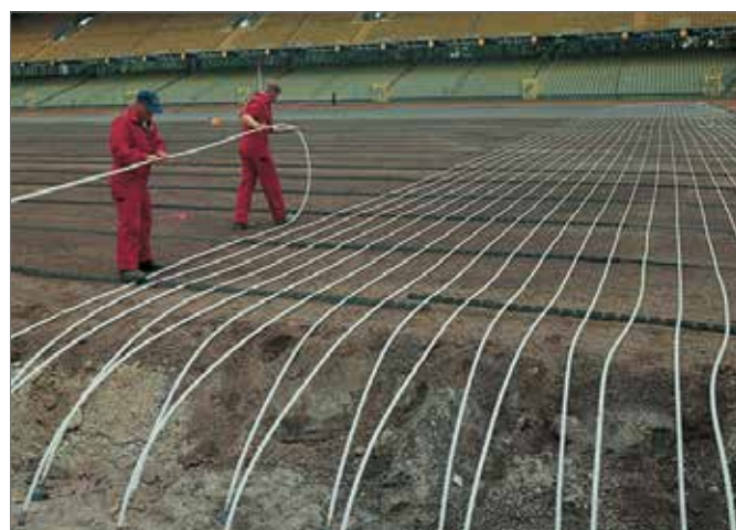
图31-35 安装加热管
