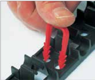
图18-46 将瑞好固定钉压入
