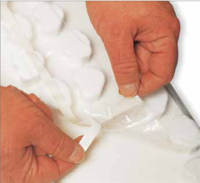
图27-2 将膜基粘贴在瑞好 Vario 蘑菇板上
