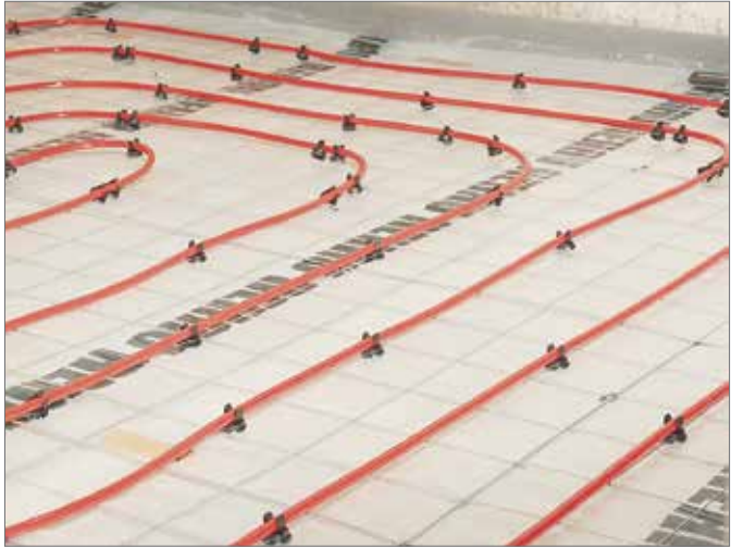
图25-50 瑞好钢丝网管夹系统
