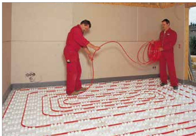
图18-27 在瑞好 Vario 蘑菇板上安装管道
