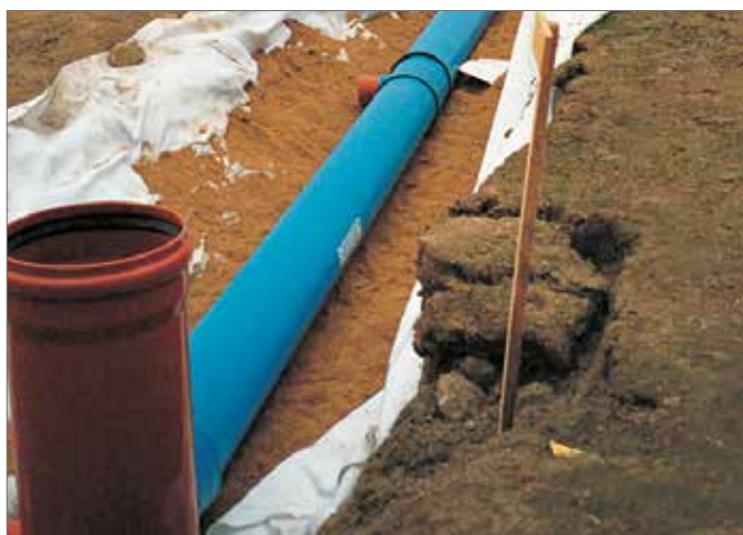
图31-32 在运动场安装排水装置
