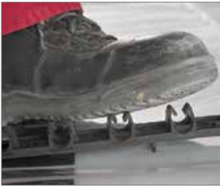
图18-45 将瑞好 RAUFIX 轨道压入
