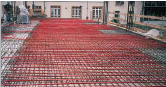
图30-4 预制混凝土部件上的瑞好BKT模块
