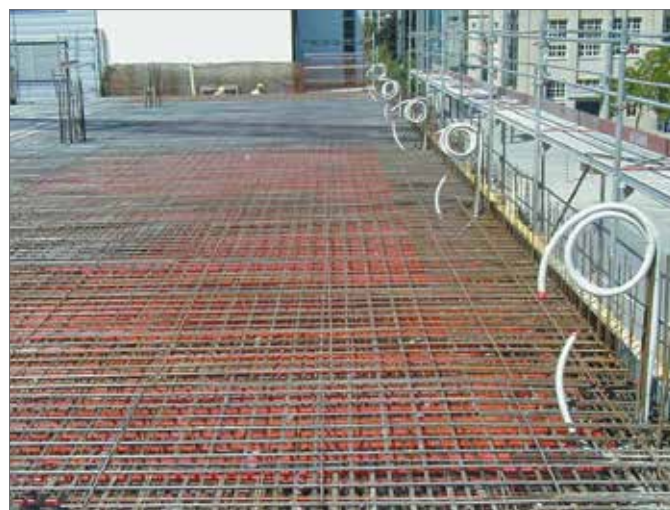
图30-2 混凝土楼板结构采暖制冷截面
