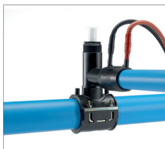
图 60 8. 在 20 分钟的冷却时间后，分支管道完成。然后对分支处的所有管线进行压力测试。
