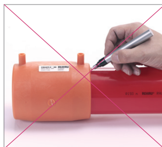
图 118 不要使用 FUSAPEX 套筒来做标记。
