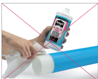
图 74 不要使用使用过的抹布来清洁管道。只允许使用不受水侵蚀、没有使用过、没有染过色或者脱纱且吸水的纤维素纸浆布。
