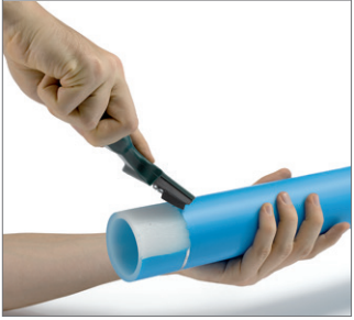
图 41 3. 用手刮刀完全去除表皮。刮除不要超过标记区。刮屑大概 0.2 mm 厚。
