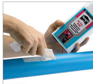
图 55 3. 刮削区域必须无尘无油脂。用足够的 Tangit 清洁剂去清洁并且等清洁剂完全挥发。
