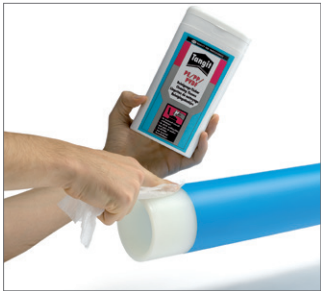
图 43 5. 刮除区域应该无尘无油脂。用足够的 Tangit 清洁剂对刮除区进行清洗，并且让清洁剂完全蒸发。
