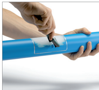
图 54 2. 在两根标记线之间，用手刮刀去除基管上半周的包覆层。残屑应有大约 0.2mm 厚。
