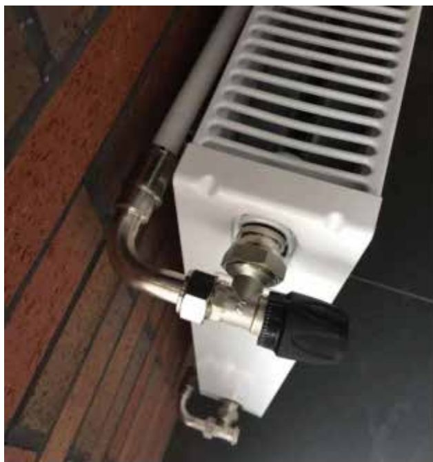
图5-17 散热器背后走管
