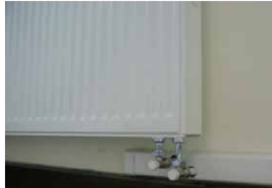
图5-12 弯曲管道进行连接
