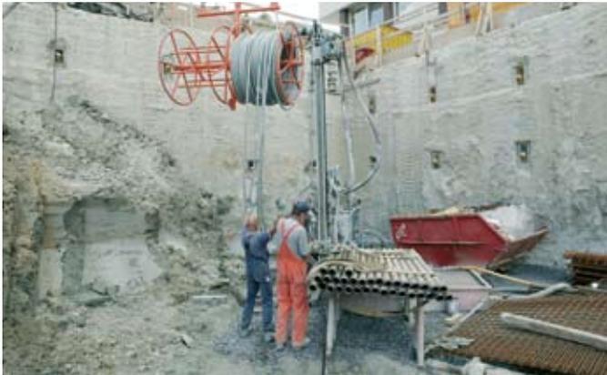
Fig. 52: Introducción de la sonda
