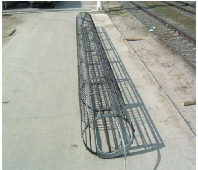
Fig. 14: Pilote energético RAUGEO
