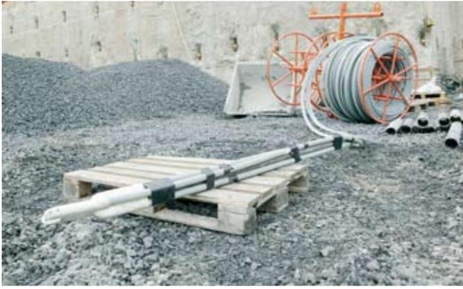
Fig. 51: Inspección y preparación de la sonda
