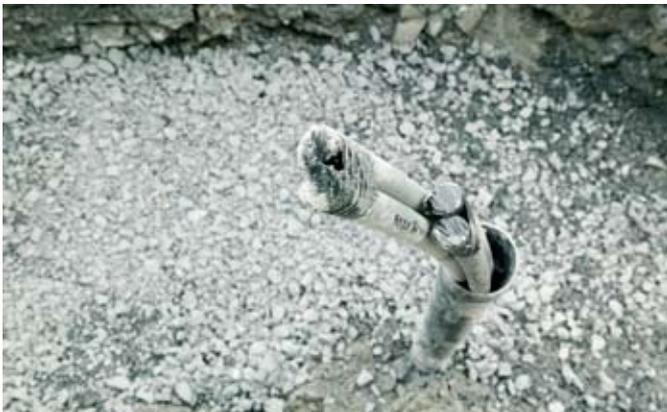
Fig. 53: Rellenado del pozo
