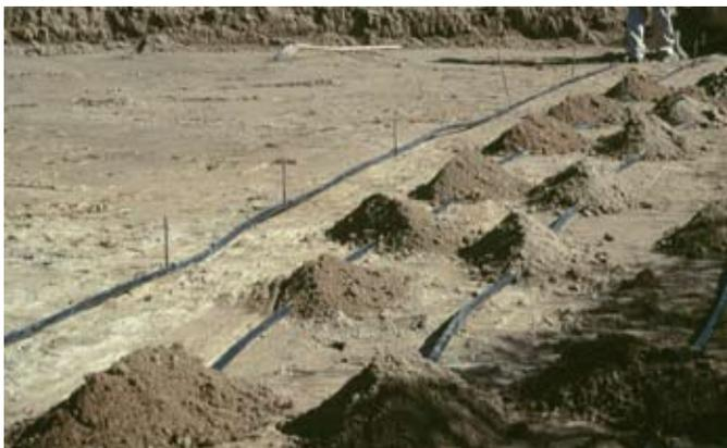
Fig. 47: Cobertura de los tubos con suelo excavado o arena
