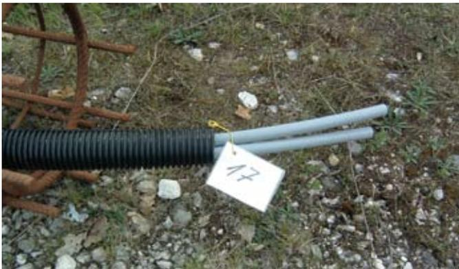
Fig. 59: Reunión de la impulsión y el retorno dentro del tubo protector
