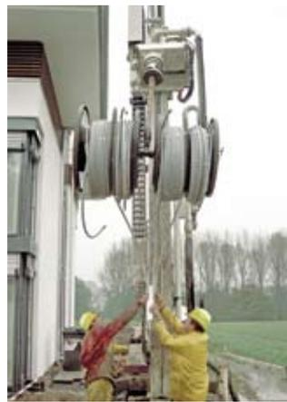
Fig. 4: Introducción de una sonda RAUGEO PE-Xa
