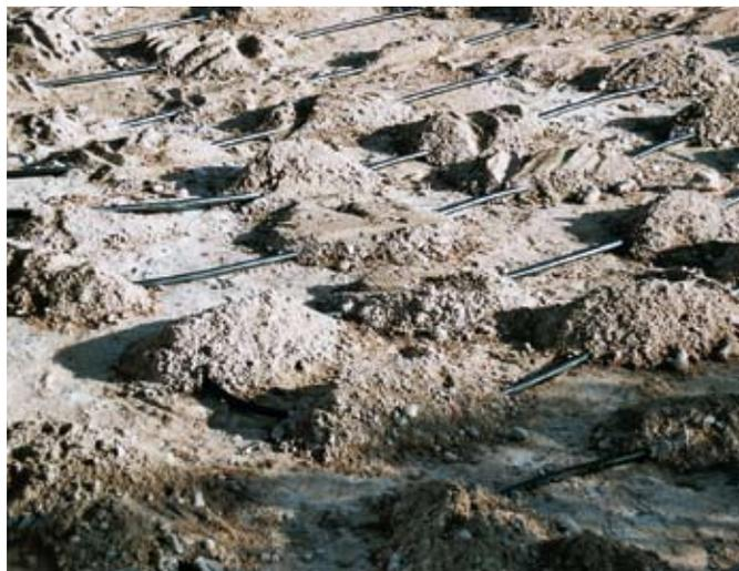
Fig. 12: Colocación del tubo RAUGEO collect PE-100
