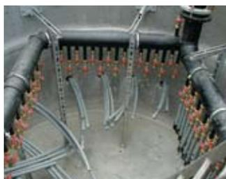
Fig. 25: Distribuidor para agua glicolada (en material polimérico)
