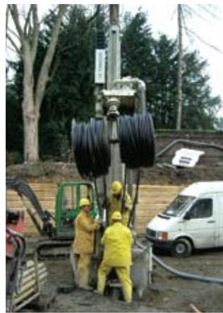
Fig. 7: Introducción de una sonda RAUGEO PE 100
