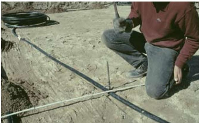
Fig. 46: Extensión y fijación del tubo
