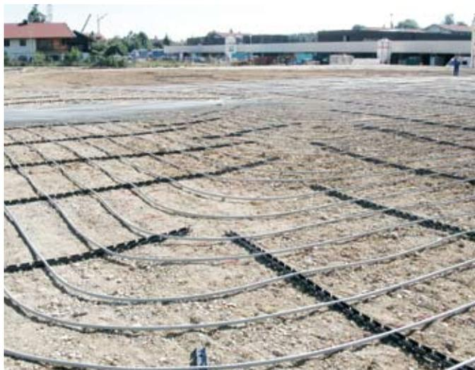
Fig. 10: Colocación del tubo RAUGEO collect PE-Xa
