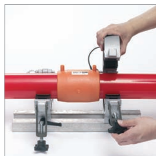
Fig. 24: Una vez vencido el tiempo de enfriamiento "cool ... min" especificado en el manguito se puede retirar el alineador de tubo universal.
