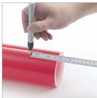
Fig. 09: Marcar la zona de raspado indicada en la tabla de la derecha. Utilizar un rotulador de color contrastante.
