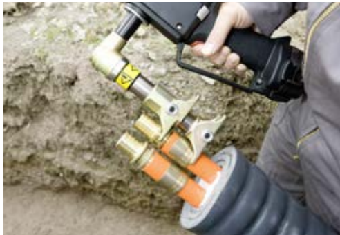
Легке з'єднання: Внутрішня труба з перевіреною понад мільйон разів технологією з'єднання REHAU за допомогою насувної гільзи
