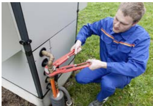
Легке підключення: Просте присіднання до тепломережі забезпечують зручні для монтажу сполучні комплекти RAUWITHERM з розмірами DUO 32 мм та 40 мм, повністю попередньо з'єднані та ізовані
