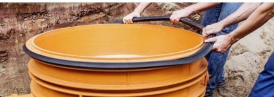
Abb. 05-27 Aufspannen der Schachtelementdichtung
