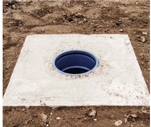
Abb. 05-1 Betonsockel mit Doppelsteckmuffe
