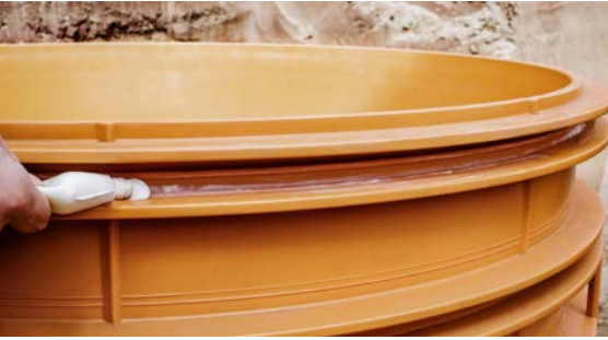
Abb. 05-26 Oberste Dichtkammer mit Gleitmittel einstreichen
