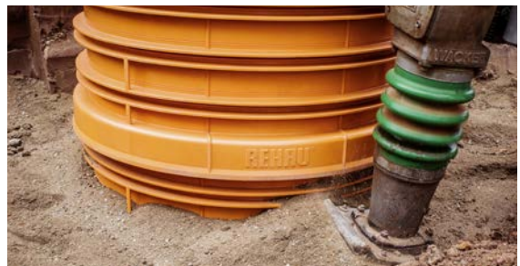
Abb. 05-31 Verfüllen und Verdichten der Schachstumgebung
