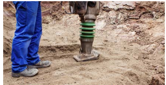
Abb. 05-25 Auflagebereich des Schachtbodens vorbereiten
