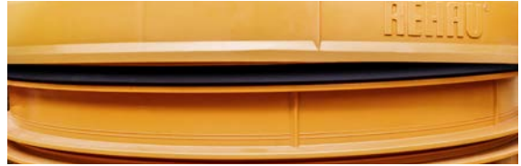
Abb. 05-30 Schachtelemente aufeinander setzen
