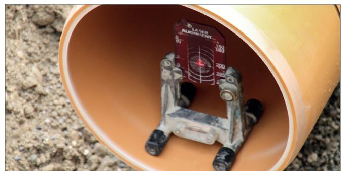
Abb. 5-11 Gefälle-Kontrolle mit einem Laser
