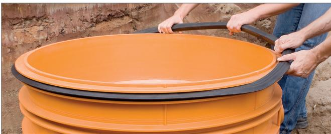
Abb. 5-26 Aufspannen der Schachtelementdichtung
