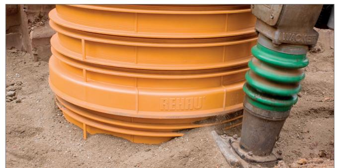
Abb. 5-30 Verfüllen und Verdichten der Schachtumgebung
