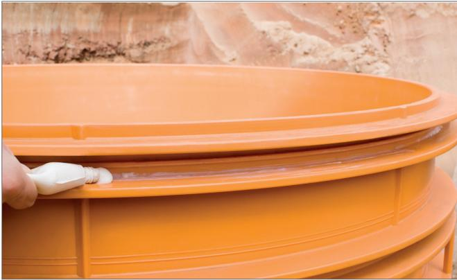
Abb. 5-25 Oberste Dichtkammer mit Gleitmittel einstreichen
