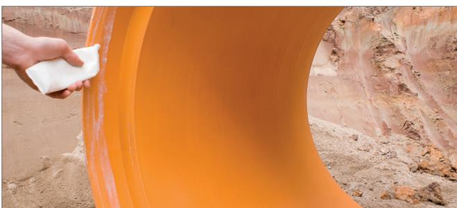
Abb. 5-28 Muffe des Schachtrings gleichmäßig mit Gleitmittel einstreichen
