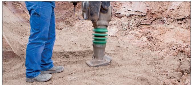
Abb. 5-24 Auflagebereich des Schachtbodens vorbereiten
