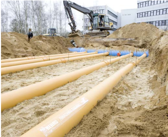
Anschluss der Wärmetauscherrohre AWADUKT Thermo antimikrobiell DN 250 an vorkonfektionierten-polypropylen Verteilerbalken
