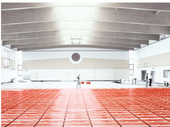
Schwingbodenheizung
