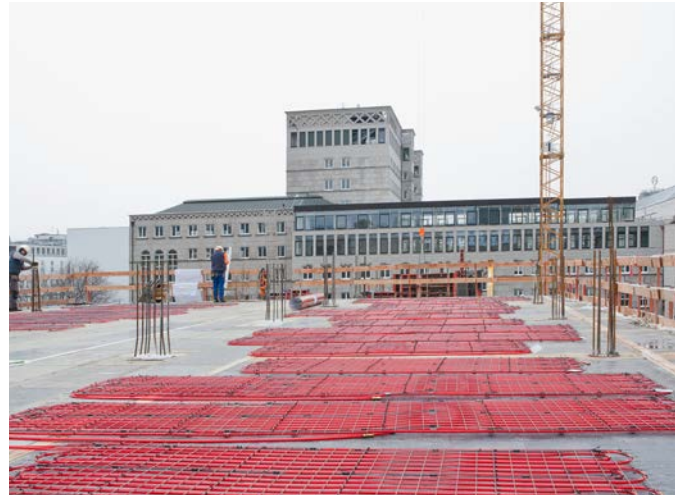
Oberflächennahe Betonkerntemperierung
