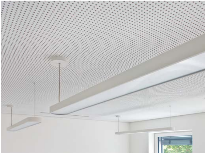
Akustikkühldecke in Trockenbauweise
