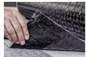
Platte mit 5 cm Mindestüberlappung an Querseite
