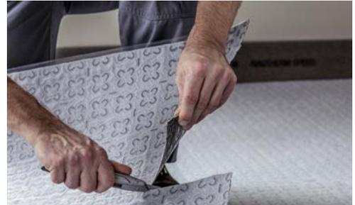
Verlegeelement ausrichten und flächig auf der unterseitigen Dämmschicht bzw. tragfähigen Untergrund fixieren.
