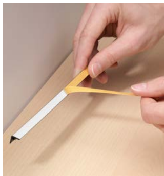
2. Klebeband ablösen
