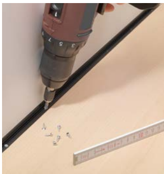
4. Anschrauben (Spanplattenschraube Senkkopf 2,5 x 10 )
