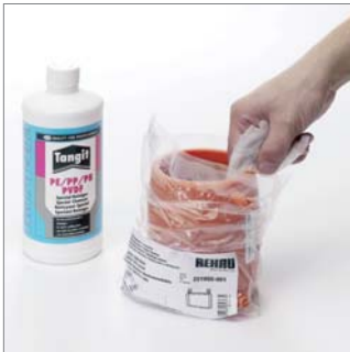
Abb. 31: Die Elektroschweißmuffe FUSAPEX erst kurz vor der Verarbeitung dem Beutel entnehmen, wenn erforderlich reinigen.
