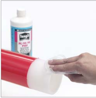
Abb. 13: Abschabbereich muss staub- und fettfrei sein. Mit ausreichend Tangit-Reiniger säubern und komplett verdunsten lassen.
