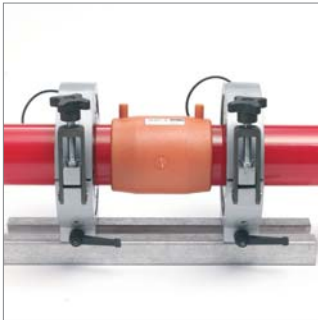
Abb. 17: Zweites Rohrende vorbereiten, in Elektroschweißmuffe vollständig einschieben und mit Rohrhalteklemmen fixieren.
