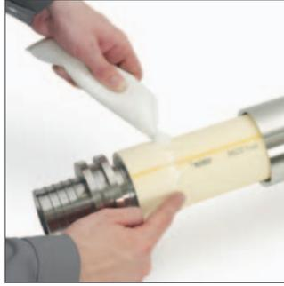
Fitting einstecken und im Verbindungsbereich am kompletten Umfang gleichmäßig mit Gleitmittel benetzen.
