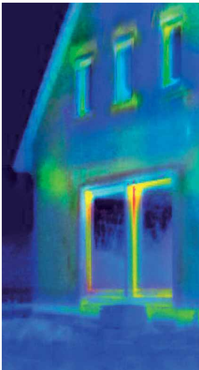
Avant rénovation : La perte thermique la plus élevée est illustrée en rouge.
