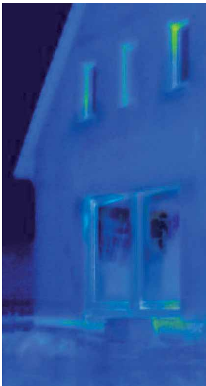
Après rénovation : la mise en œuvre de la porte levante coulissante GENEÓ réduit sensiblement la perte thermique.
