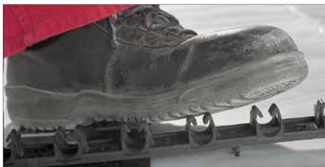
Fig. 11-5 Premere il binario RAUFIX nella struttura del pavimento
