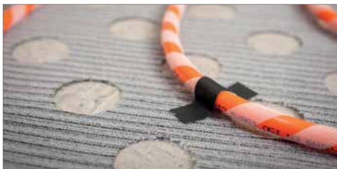
Fig. 7-21 Esempio di applicazione del nastro di fissaggio RAUTHERM SPEED
