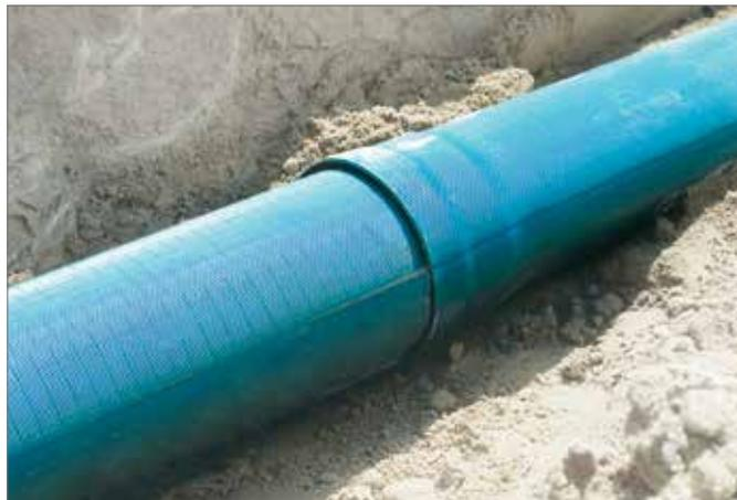
Fig. 15-29 Posa del drenaggio sul campo da gioco
