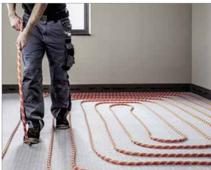
Fig. 7-15 Installazione del tubo
