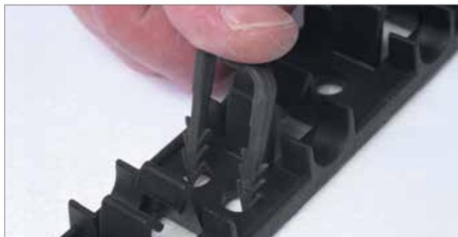
Fig. 11-6 Spingere i chiodi di fissaggio nel pannello isolante
