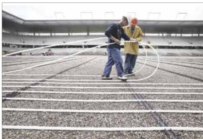
Fig. 15-30 Posa dei tubi per il riscaldamento
