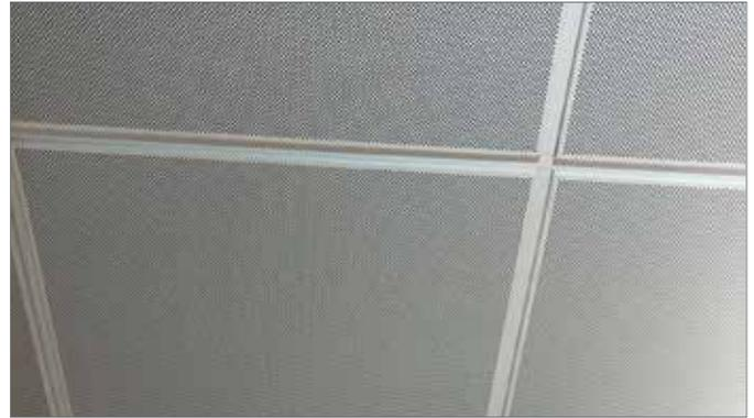
Fig. 13-2 Soffitto radiante ispezionabile installato
