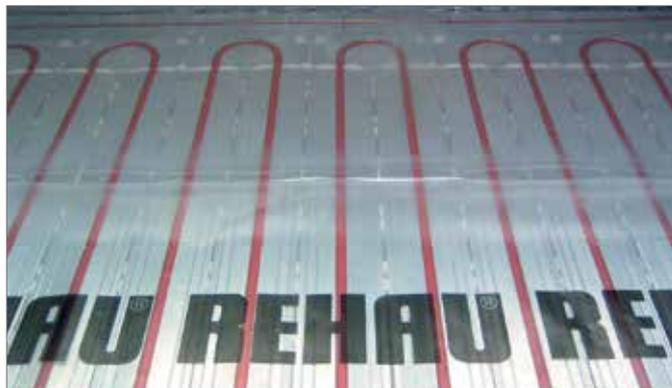
Fig. 10-11 Sistema a secco TS-14 per il sistema di riscaldamento
