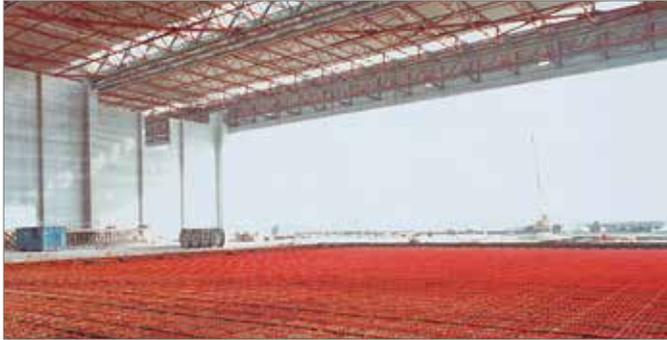
Fig. 15-1 Riscaldamento a pavimento in un capannone industriale
