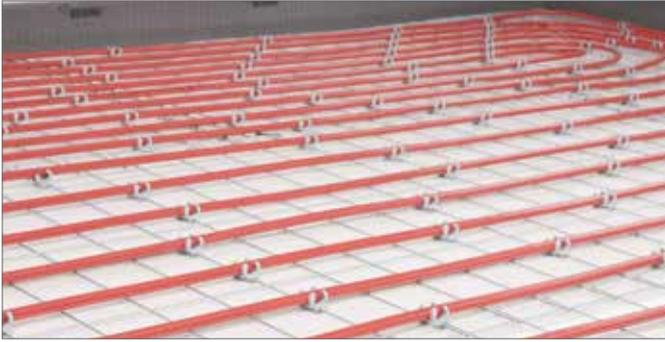
Fig. 11-8 Sistema a Rete Metallica per il fissaggio dei tubi
