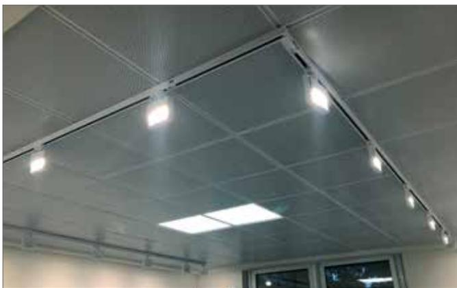
Fig. 13-1 Soffitto radiante ispezionabile installato
