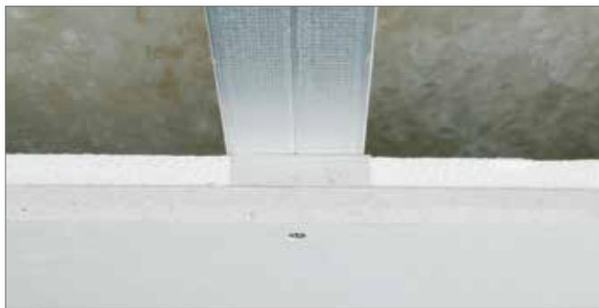
Fig. 13-9 Elemento a soffitto montato
