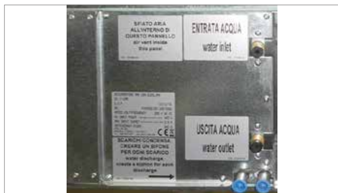
Fig. 5-2 Collegamenti idraulici
