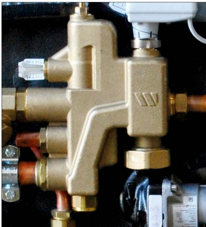
Fig. 07-5 Valvola a tre via Modulante 0/10V
