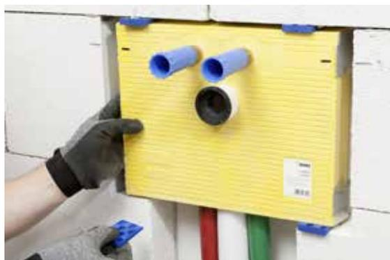
Fig. 06-23 Variante 2 - fissaggio con cunei
