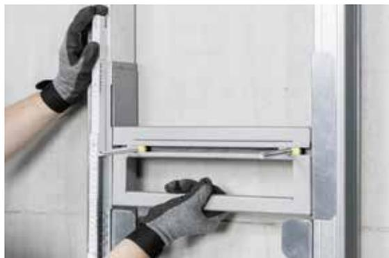
Fig. 06-9 Regolazione dell'altezza del supporto portante RSB
