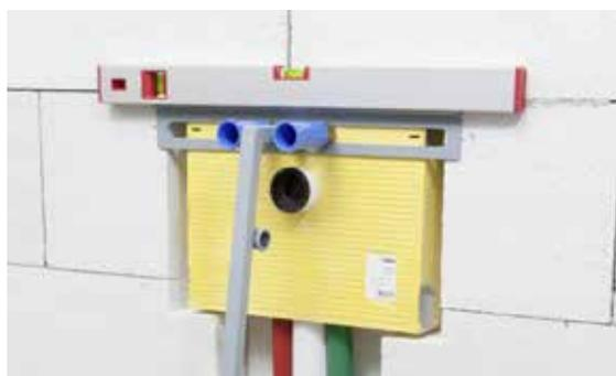
Fig. 06-22 Variante 1 - fissaggio con dima
