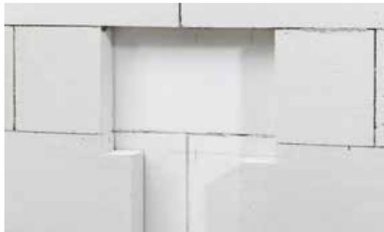
Fig. 06-21 Realizzazione della cavità
