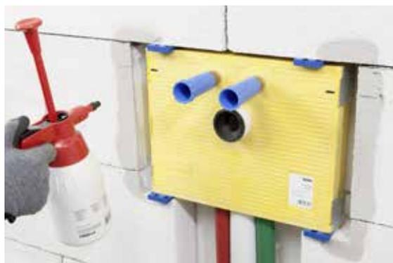
Fig. 06-24 Come inumidire moduli sanitari e sottofondo
