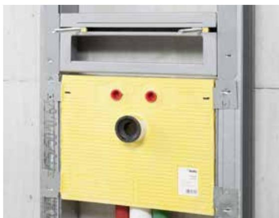
Fig. 06-12 Crimpatura di un modulo sanitario di larghezza 350 mm
