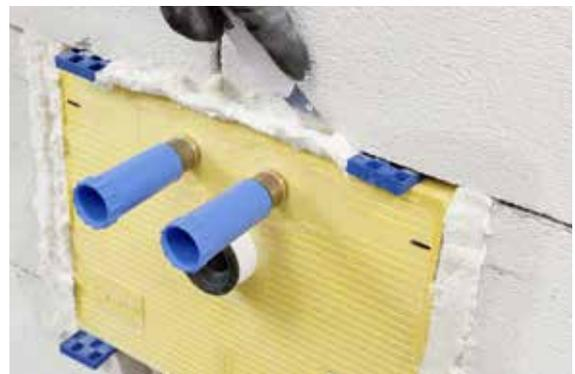
Fig. 06-27 Rimozione della schiuma in eccesso
