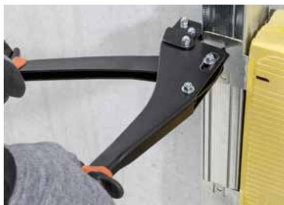
Fig. 06-6 Crimpatura della prima aletta di fissaggio
