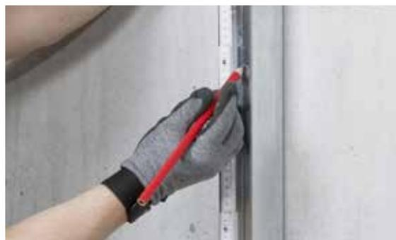
Fig. 06-4 Segnare l'altezza di installazione
