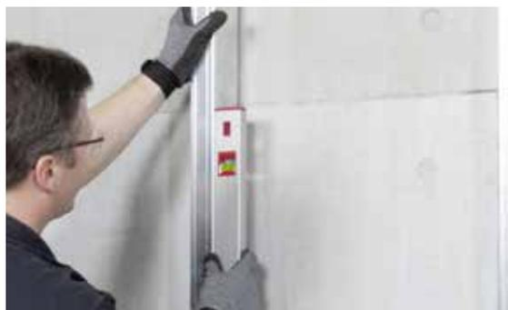
Fig. 06-1 Allineare i profili per il montaggio a secco
