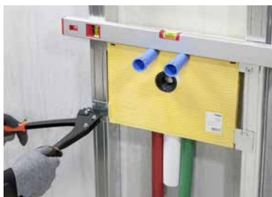
Fig. 06-7 Allineamento e crimpatura delle alette di fissaggio
