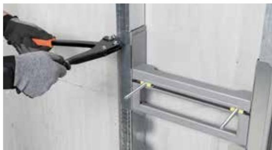
Fig. 06-10 Crimpatura del supporto RSB
