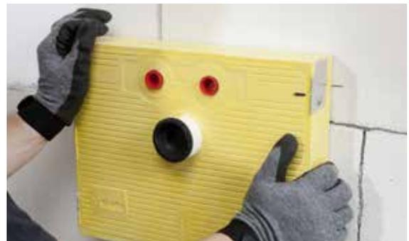
Fig. 06-19 Incollaggio del modulo sanitario
