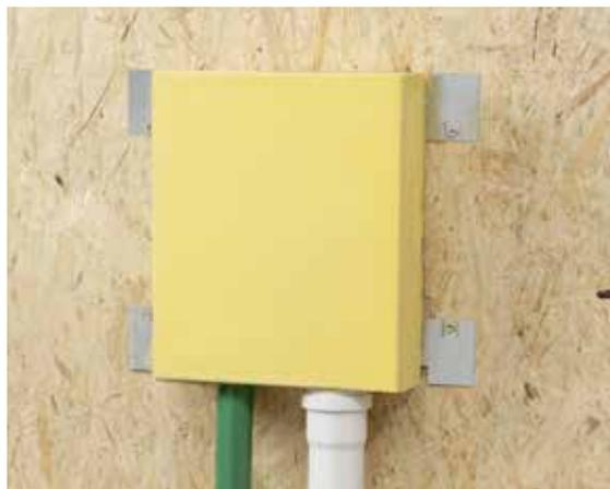
Fig. 06-30 Fissaggio con pannelli in truciolato
