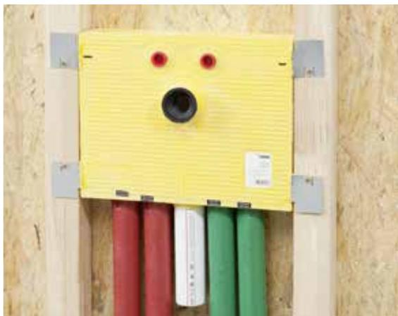
Fig. 06-29 Fissaggio su struttura di supporto in legno
