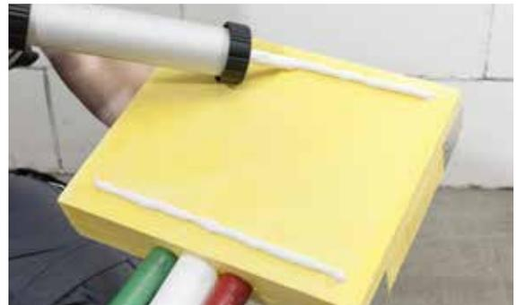
Fig. 06-18 Applicazione di RSB colla di montaggio
