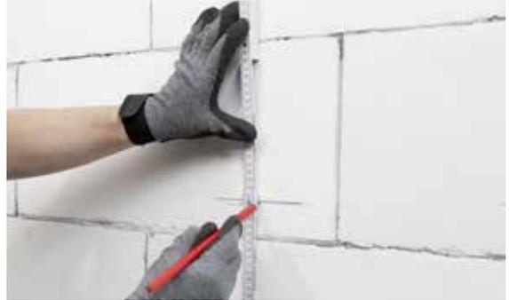
Fig. 06-13 Tracciare la posizione del modulo
