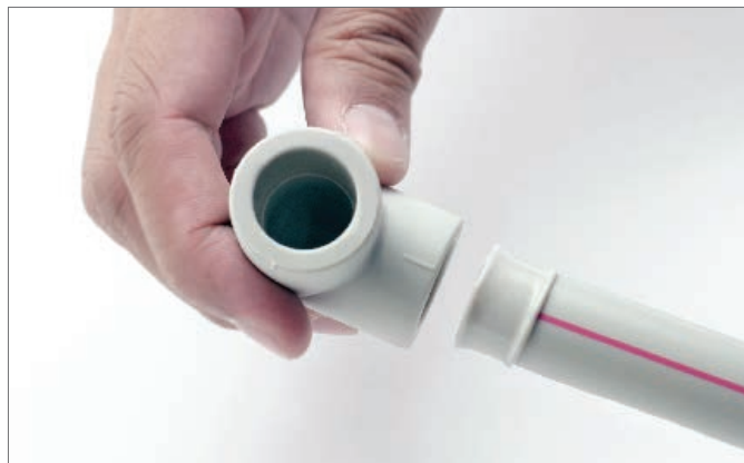
图 8-7 对齐管道和管件
