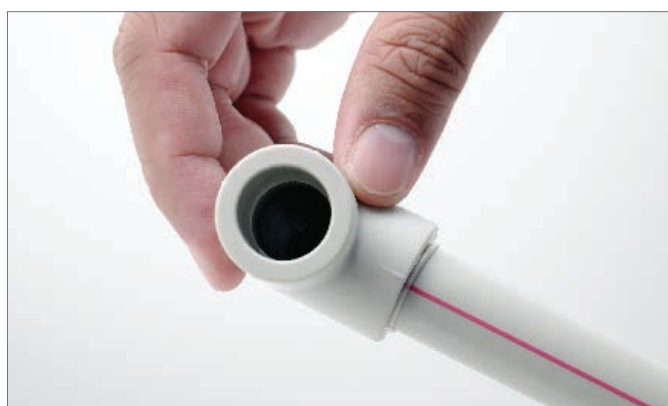
图 8-8 连接管道和管件
