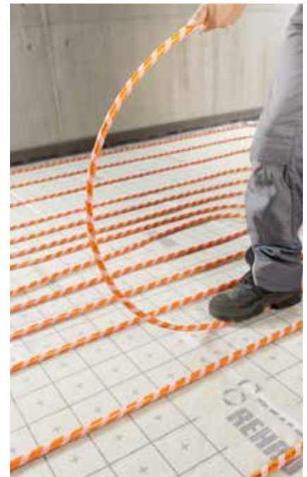
Typisch aan dit systeem is de bevestiging met klittenband. (Foto: REHAU)
