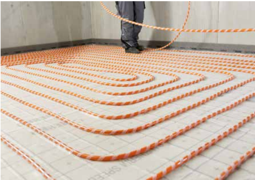
Dankzij de bevestiging met klittenband, hoeft de akoestische isolatielaag niet doorboord te worden. Dat levert een beter akoestisch comfort op. (Foto: REHAU)
