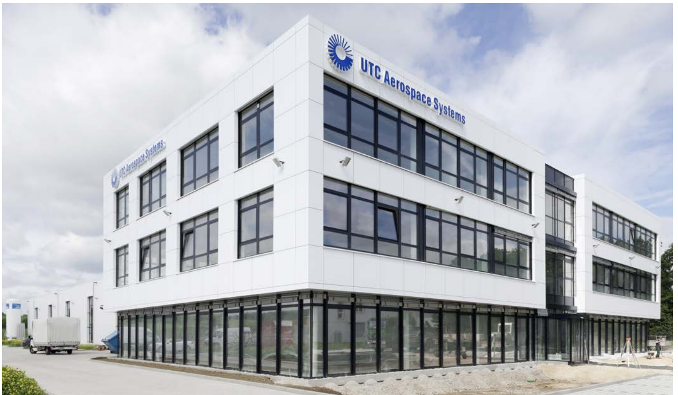
Oberflächennahe Betonkerntemperierung, Büro- und Verwaltungsgebäude
