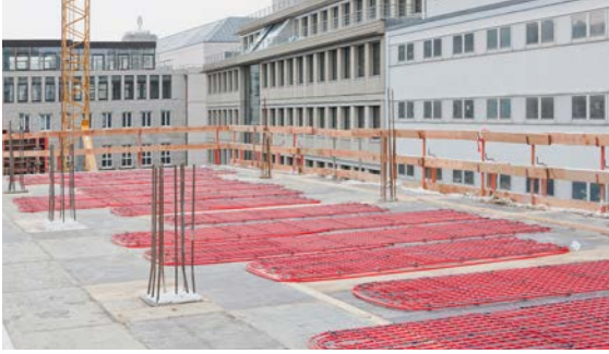
Abb. 05-11 Positionierte oBKT-Module
