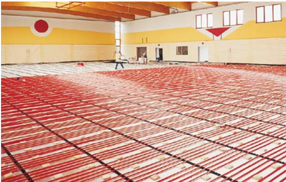
Abb. 07-14 Schwingbodenheizung mit Industrieverteiler
