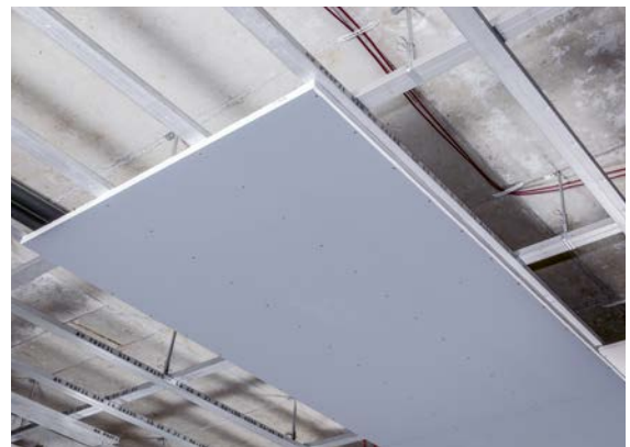
Abb. 04-11 Montiertes Deckenelement
