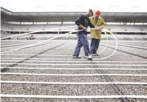
Abb. 09-2 Heizungsrohre verlegen
