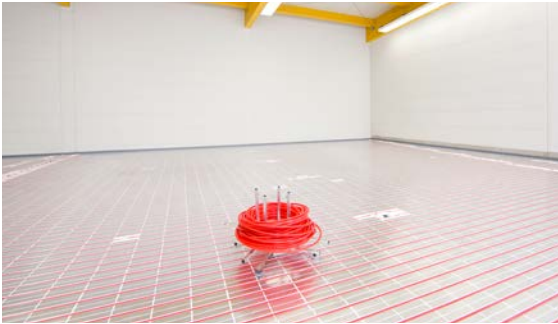
Abb. 07-1 Trockensystem mit flächenelastischem Sportboden
