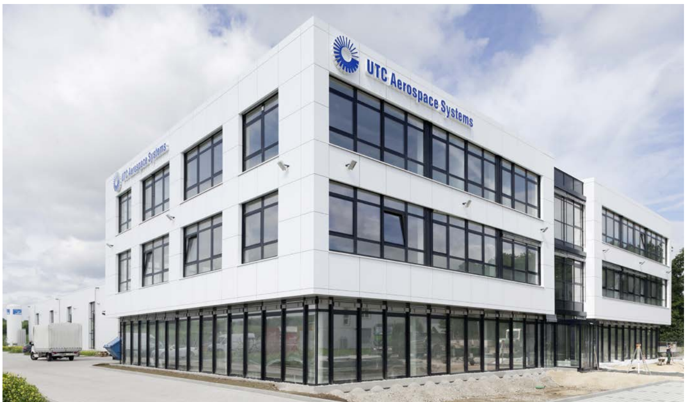
Oberflächennahe Betonkerntemperierung, Büro- und Verwaltungsgebäude
