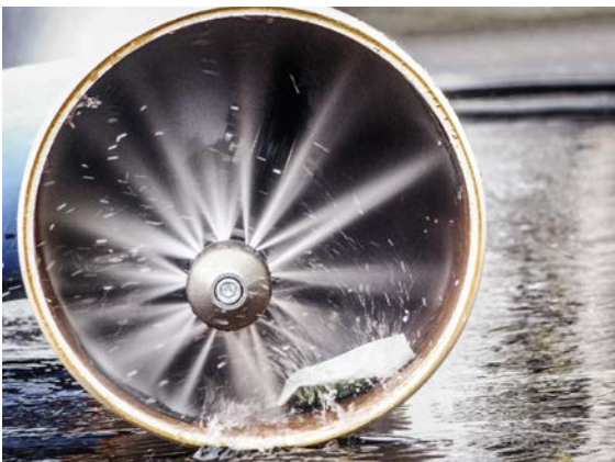
Abb. 06-2 Reinigung mit Wasserhochdruck
