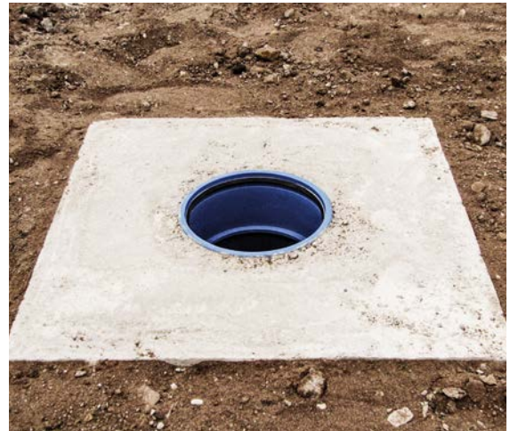
Abb. 05-1 Betonsockel mit Doppelsteckmuffe
