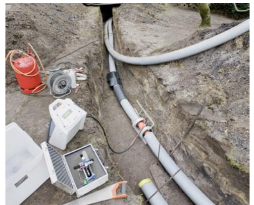
Verteilung der Wärme mit RAUTHERMEX-Rohren
