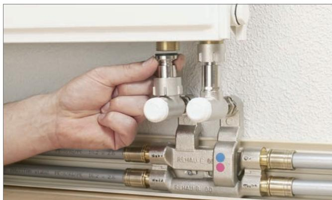
Abb. 17-22 Anschluss Teleskop-Eckverschraubungs-Set
