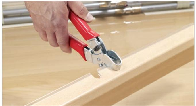
Abb. 17-41 Sockelleistenkanal-Oberteil ausklinken
