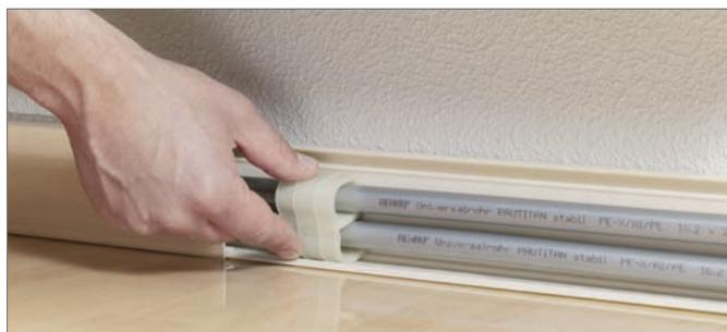
Abb. 17-31 Heizungsrohrträger einclippen
