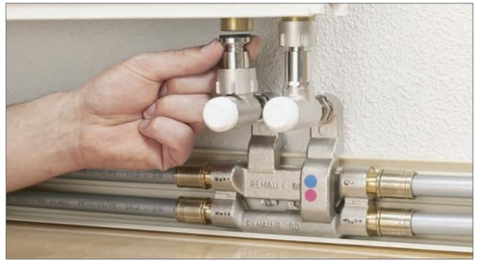
Abb. 17-32 Teleskop-Eckverschraubungs-Set an den Ventilheizkörper anschließen
