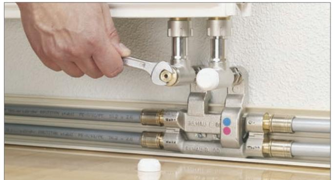
Abb. 17-33 Klemmringverschraubung fest anziehen
