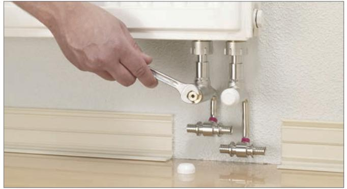
Abb. 17-40 Klemmringverschraubung fest anziehen
