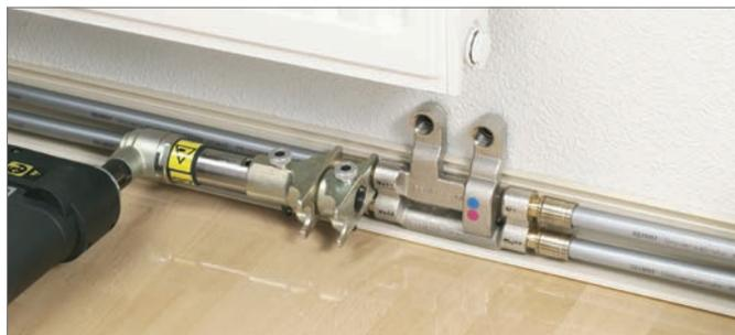
Abb. 17-28 Schiebehülseverbindung Abmessung 16 am SL-Kreuzungsfitting-Set RAUTITAN 16 - 12 - 16
