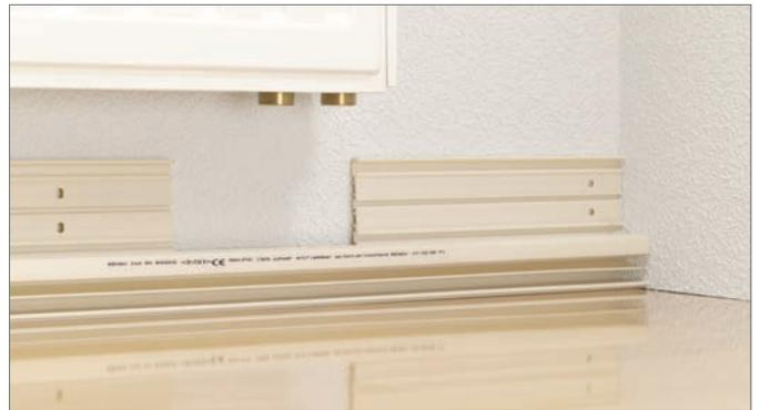
Abb. 17-38 Montiertes Sockelleistenkanal-Unterteil RAUDUO mit Aussparung
