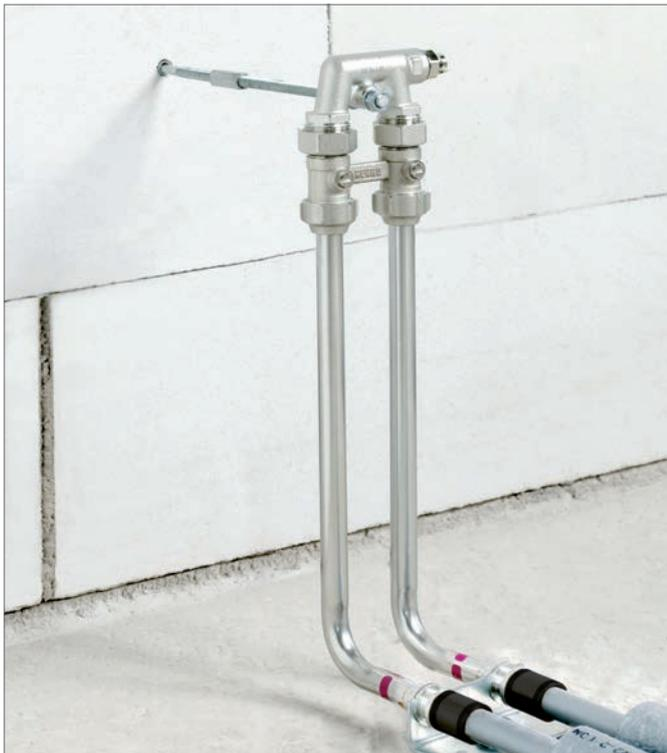
Abb. 16-10 Montagebrücke mit Entlüfter, Anschluss aus dem Boden Einbaubeispiel
