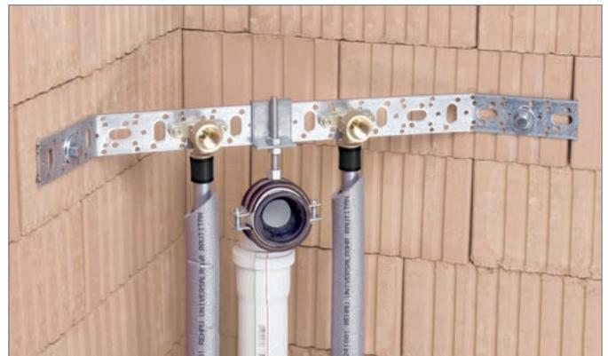
Abb. 5-3 Einbaubeispiel Montageschiene
