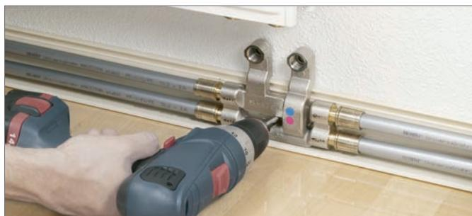
Abb. 17-30 SL-Kreuzungsfitting RAUTITAN befestigen
