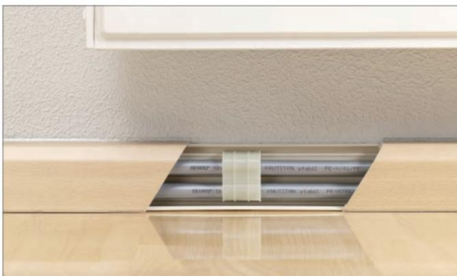
Abb. 17-20 Heizungsrohrträger im Sockelleistenkanal RAUSOLO
