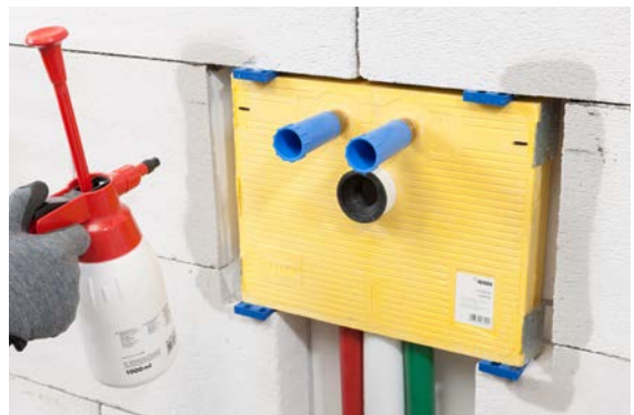
Abb. 06-20 Anfeuchten von Sanitärbox und Untergrund
