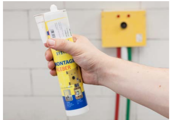
Abb. 06-13 Verwendung des Montageklebers
