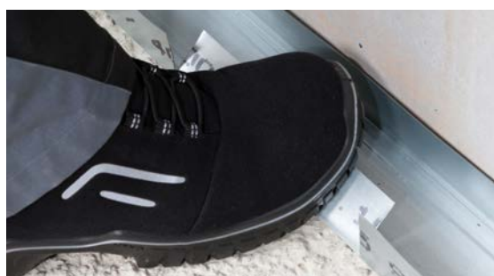
Abb. 06-3 Umbiegen des eingeschnittenen des UW-Profils
