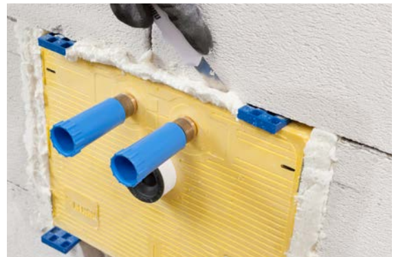
Abb. 06-23 Überstehenden Schaum entfernen
