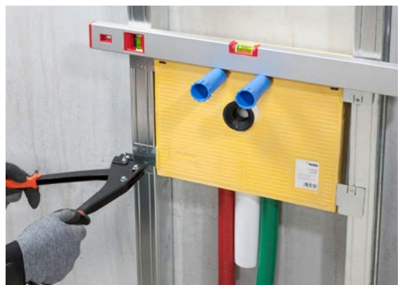
Abb. 06-7 Ausrichten und Verkrümpfen der Befestigungslaschen
