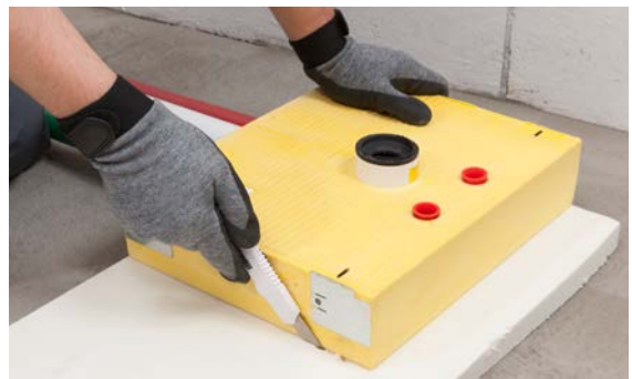
Abb. 06-11 Zuschnitt alternativer Distanzplatten
