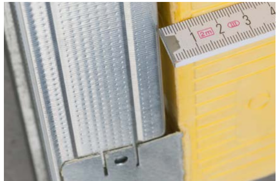
Abb. 06-5 Einpassen der Sanitärbox
