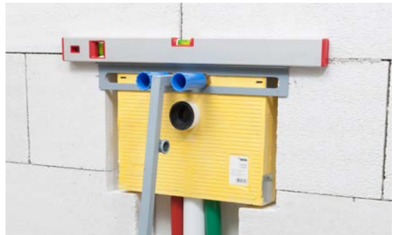
Abb. 06-18 Variante 1 – Fixierung mit Montagelehre
