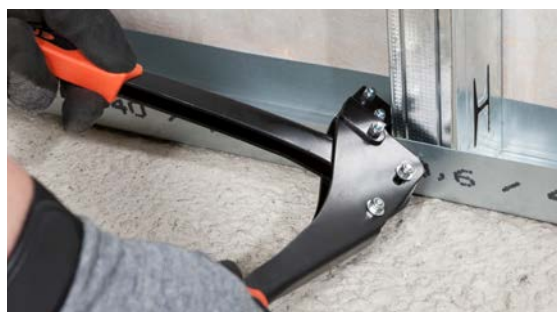
Abb. 06-2 Verbinden von CW- mit UW-Profil
