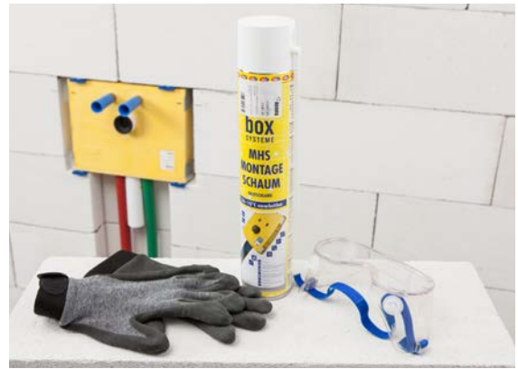
Abb. 06-21 Verwendung des Montageschaums
