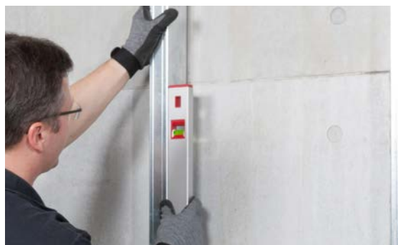
Abb. 06-1 Ausrichten der Trockenbau-Profile
