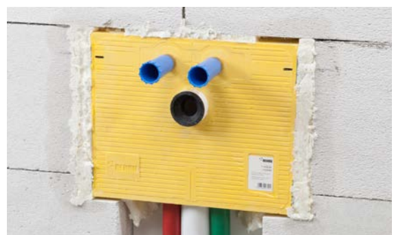
Abb. 06-24 Volle Belastbarkeit nach 24 Stunden
