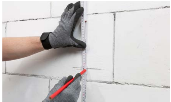
Abb. 06-9 Anzeichnen der Box-Position
