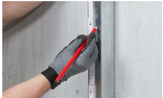
Abb. 06-4 Anzeichnen der Installationshöhe
