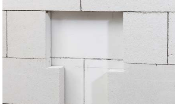
Abb. 06-17 Erstellung der Aussparung
