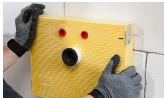
Abb. 06-15 Ankleben der Sanitärbox
