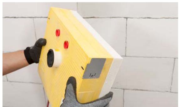
Abb. 06-12 Vorbereitung der Verklebung
