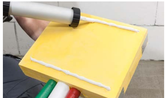
Abb. 06-14 Auftragen des Montageklebers
