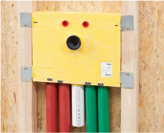
Abb. 06-25 Befestigung bei Holzständer-Bauweise
