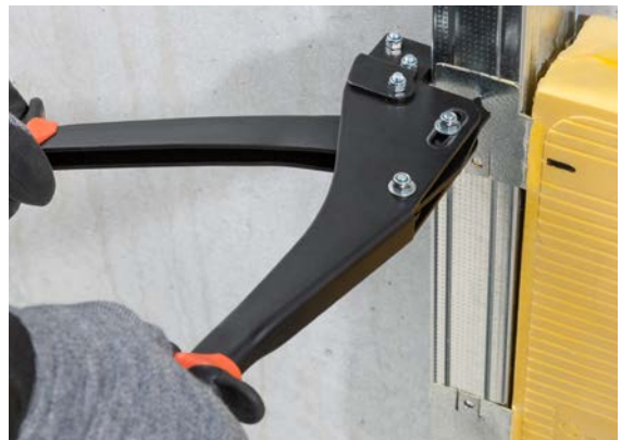
Abb. 06-6 Verkrümpfen der ersten Befestigungslasche
