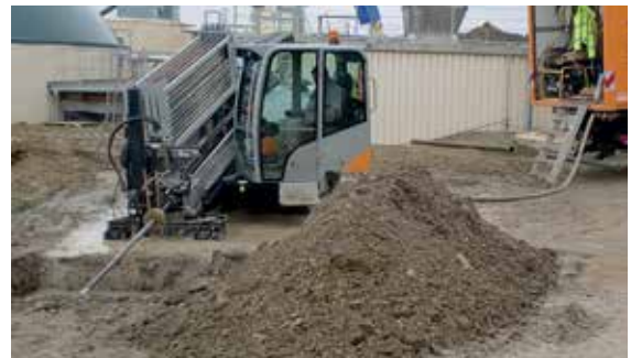
Fig. 07-10 Posa con bobina perforante
