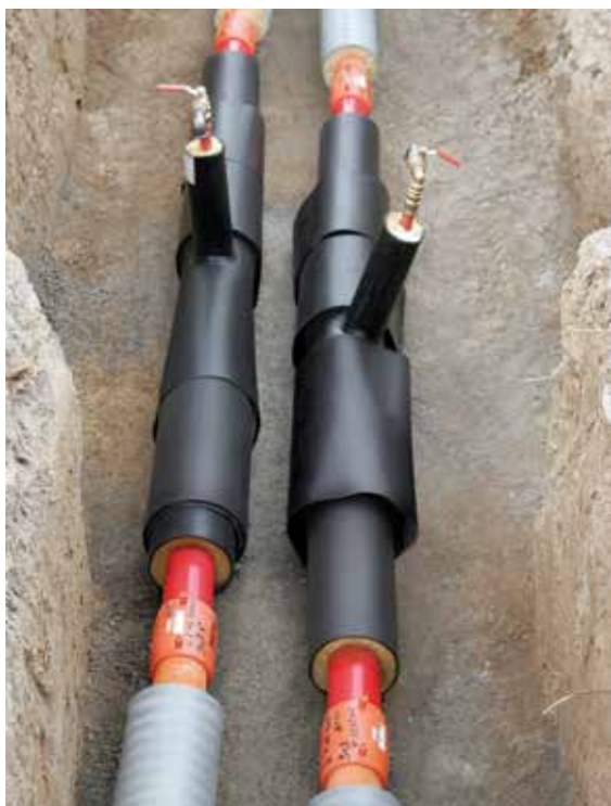
Fig. 07-27 Collegamento dei tubi
