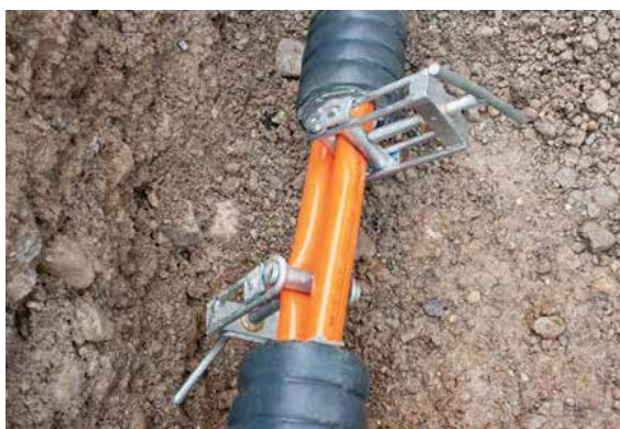
Fig. 07-31 Compressione tubo interno DUO
