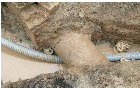
Fig. 07-24 Posa semplice grazie alla flessibilità delle tubazioni.
