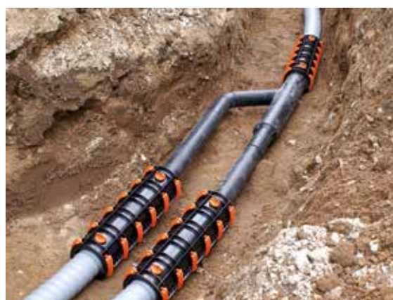
Fig. 04-30 Installazione del tubo a tre vie a Y
