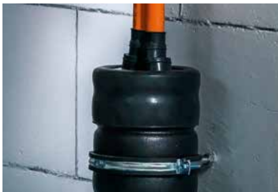
Fig. 05-23 Chiusura tubo con tappo terminale in gomma
