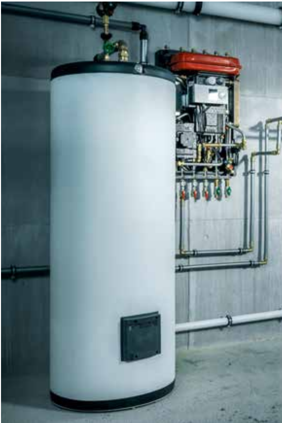
Fig. 06-9 Generatore di calore decentralizzato
