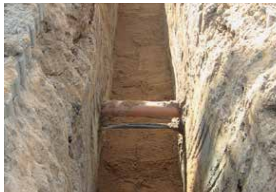
Fig. 07-2 Fondo della trincea con supporto del tubo
