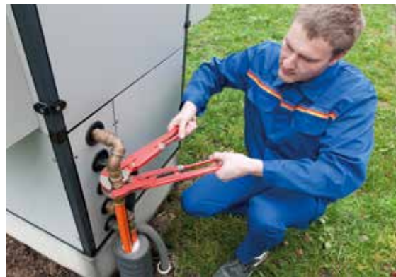
Fig. 04-17 Collegamento pompa di calore
