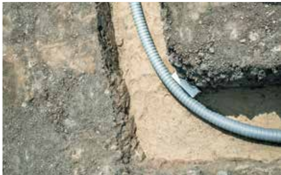
Fig. 07-23 Cambio di direzione senza raccorderia
