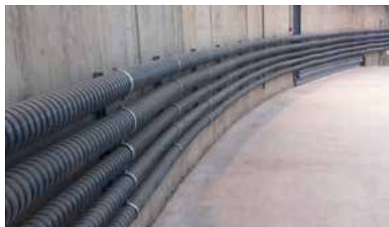
Fig. 07-28 Esempio di posa libera / montaggio a parete
