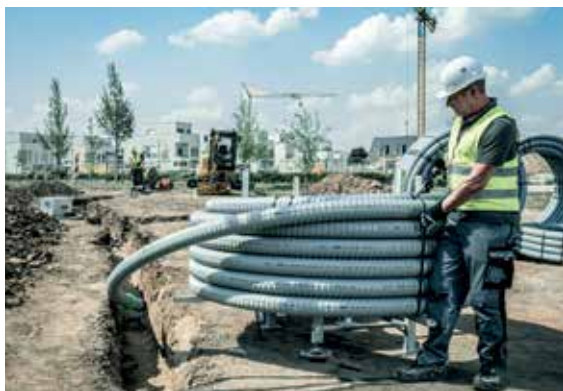
Fig. 07-32 Svolgitore orizzontale fisso alla fine della trincea
