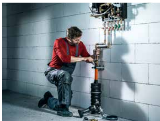
Fig. 05-2 Stazione di collegamento
