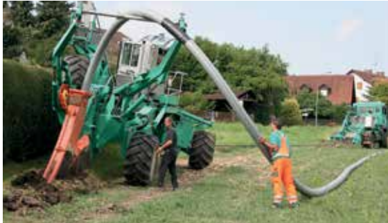
Fig. 07-8 Posa con aratro per tubi
