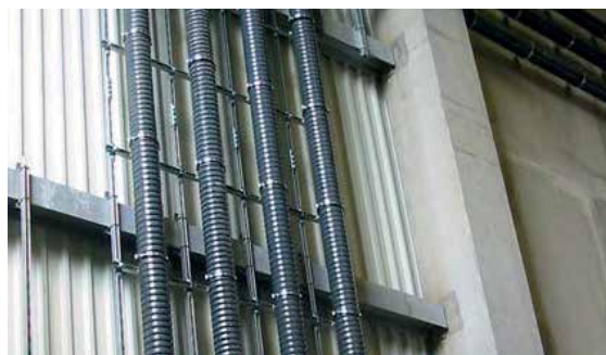
Fig. 07-29 Esempio di posa libera / montaggio a parete
