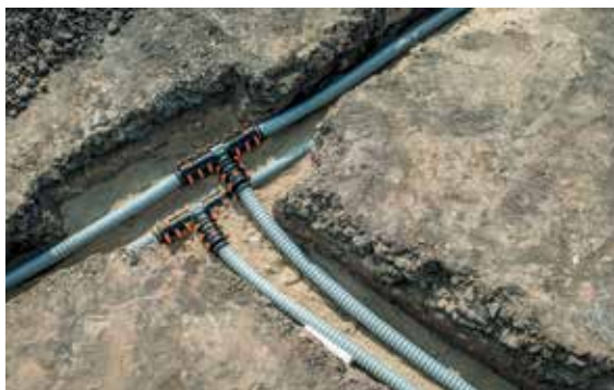
Fig. 07-4 Posa a scavo scoperto
