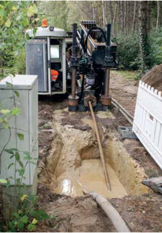
Fig. 07-13 Bobina perforante RAUTHERMEX
