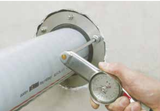
Fig. 05-12 Montaggio con chiave dinamometrica
