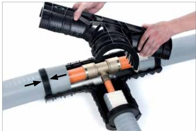
17. Reinigen Sie die Klebeflächen der beiden Schalen, damit diese frei von Schmutz und Fett sind.
